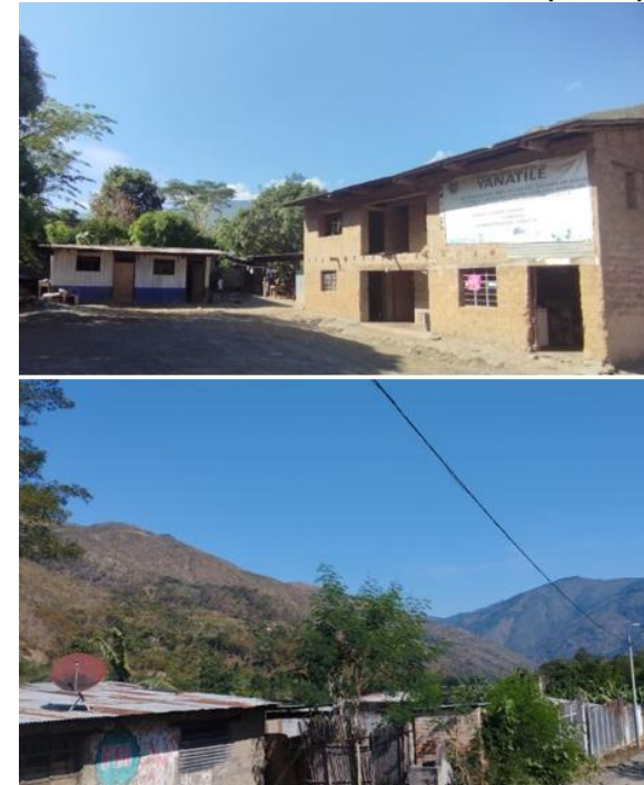
FOTOGRAFIA N° 2.6-55: Viviendas con distribución por bloques
