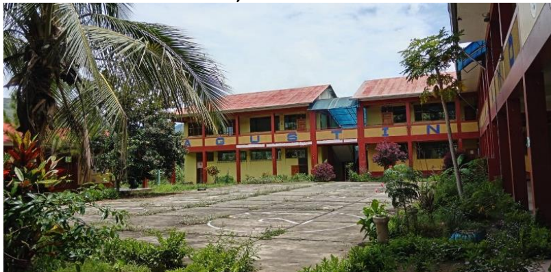
FOTOGRAFIA N° 2.6-12: Edificación en Mal estado de conservación
