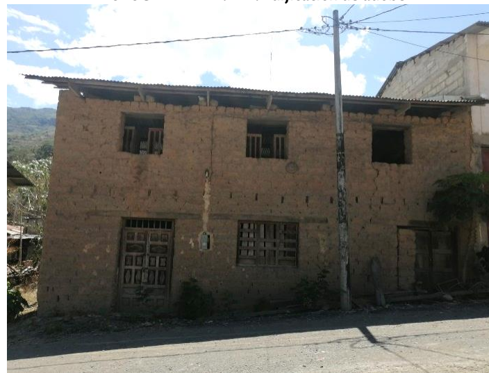
FOTOGRAFIA N° 2.6-10: Edificación de adobe
