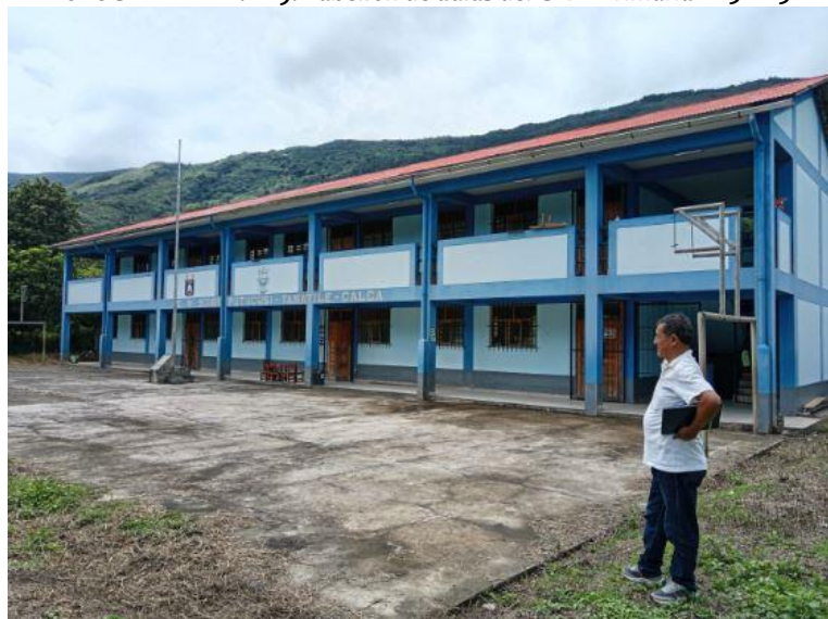
FOTOGRAFIA N° 2.6-29: Pabellón de aulas del CEBR Primaria N° 50165
