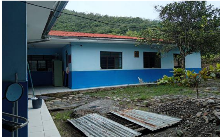
FOTOGRAFIA N° 2.6-35: Exterior del Centro de Salud Putucusi
