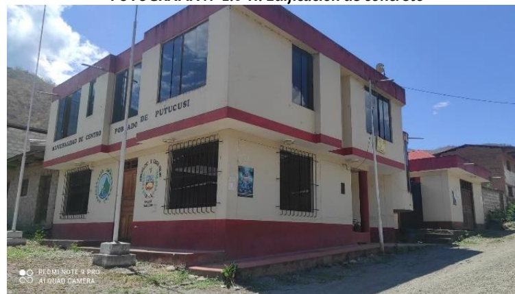
FOTOGRAFIA N° 2.6-11: Edificación de concreto
