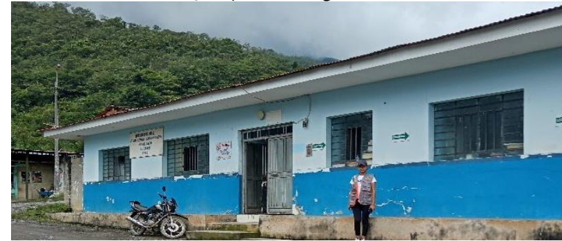
FOTOGRAFIA N° 2.6-13: Edificación en regular estado de conservación
