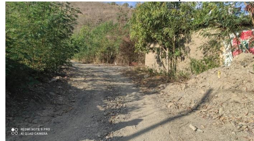
FOTOGRAFIA N° 2.6-20: Vía Trocha sin Afirmar
