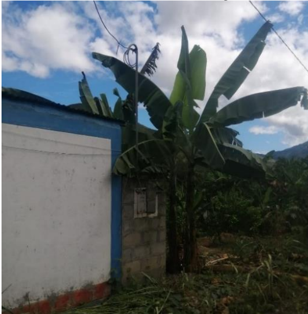
FOTOGRAFIA N° 2.6-63: Instalación de servicio de energía eléctrica a las viviendas
