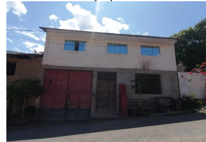
FOTOGRAFIA N° 2.6-9: Edificaciones de 02 niveles
