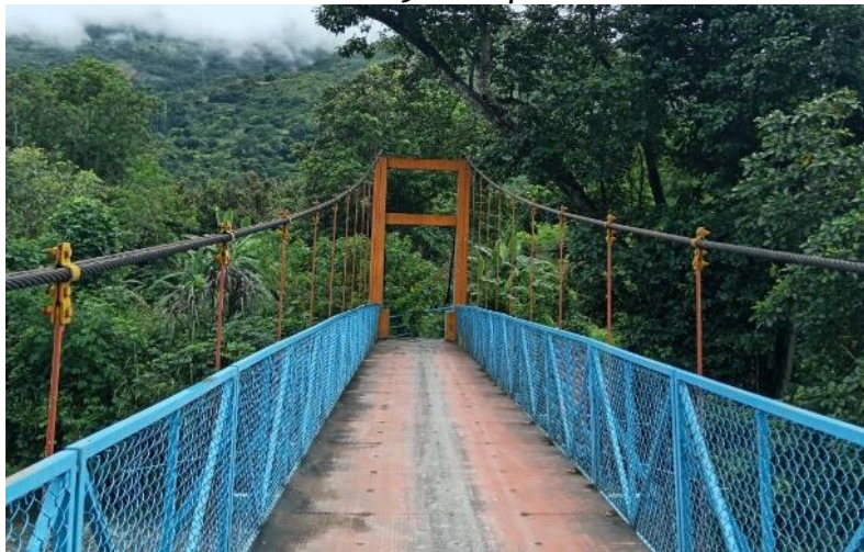
FOTOGRAFIA N° 2.6-23: Puente peatonal Putucusi
